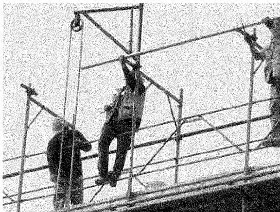
Un cantiere edile
